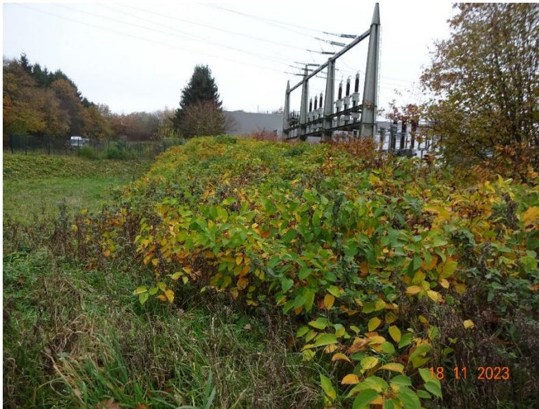
Abbildung 23: Jap. Staudenknöterich am Umspannwerk
